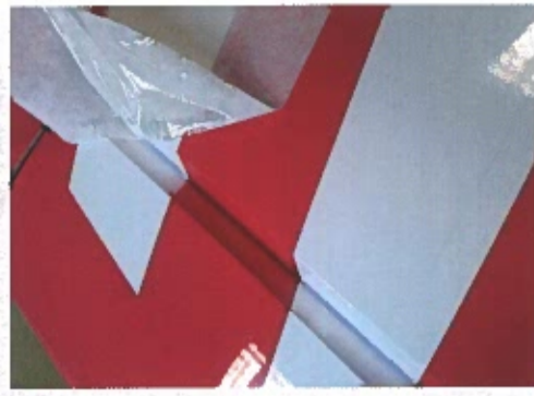
Keine Angst vor Kanten. Auch im Nassverfahren wird die Folie mit einem Lineal in die Kanten eingedrückt und die Feuchtigkeit ausgestrichen. Hier sollte man mit dem Abziehen der Transferfolie einen Tag warten, damit die Folie richtig auf dem Untergrund haftet.
