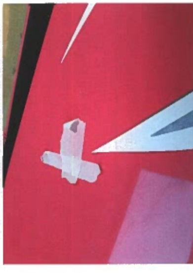
Eine (wirklich) spitze Nadel hilft beim Entfernen von Luftblasen. Es wird nur die Folie eingestochen und dann die Luft ausgedrückt. Damit sollte man aber ruhig einen Tag warten, denn etliche Blasen verschwinden von ganz allein.
